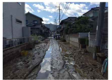
津久見駅周辺部の住宅地
