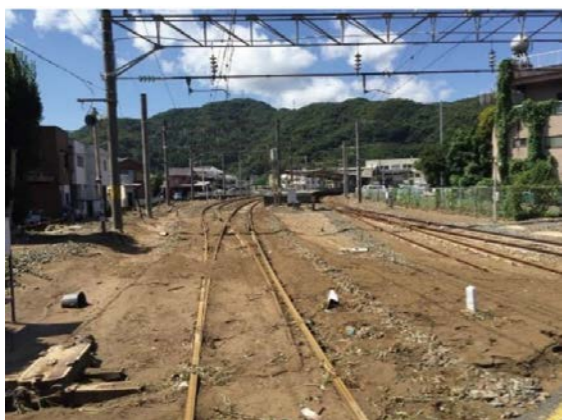
JR津久見駅構内の被害
