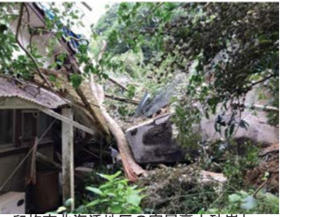
臼杵市北海添地区の家屋裏土砂崩れ
