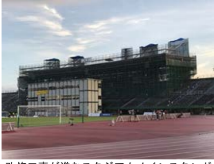
改修工事が進むスタジアムメインスタンド
