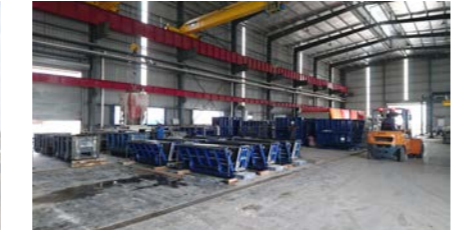
整理が行き届いた工場内部
