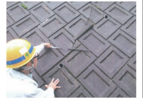
益城町で被災した擁壁を調査する被災宅地危険度判定士
