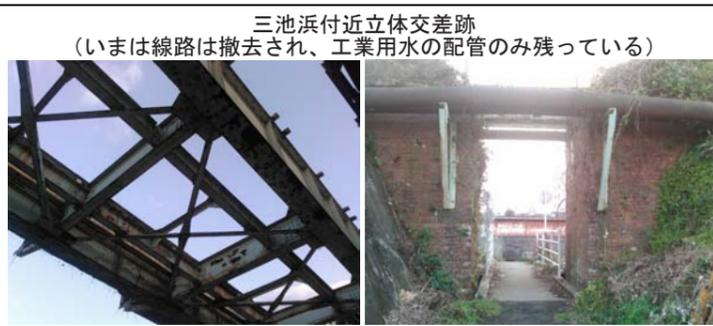
三池浜付近立交差跡(いまは線路は撤去され、工業用水の配管のみ残っている)
