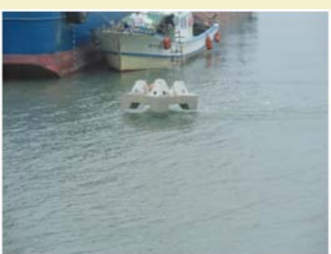
木毛セメント板沈設状況
